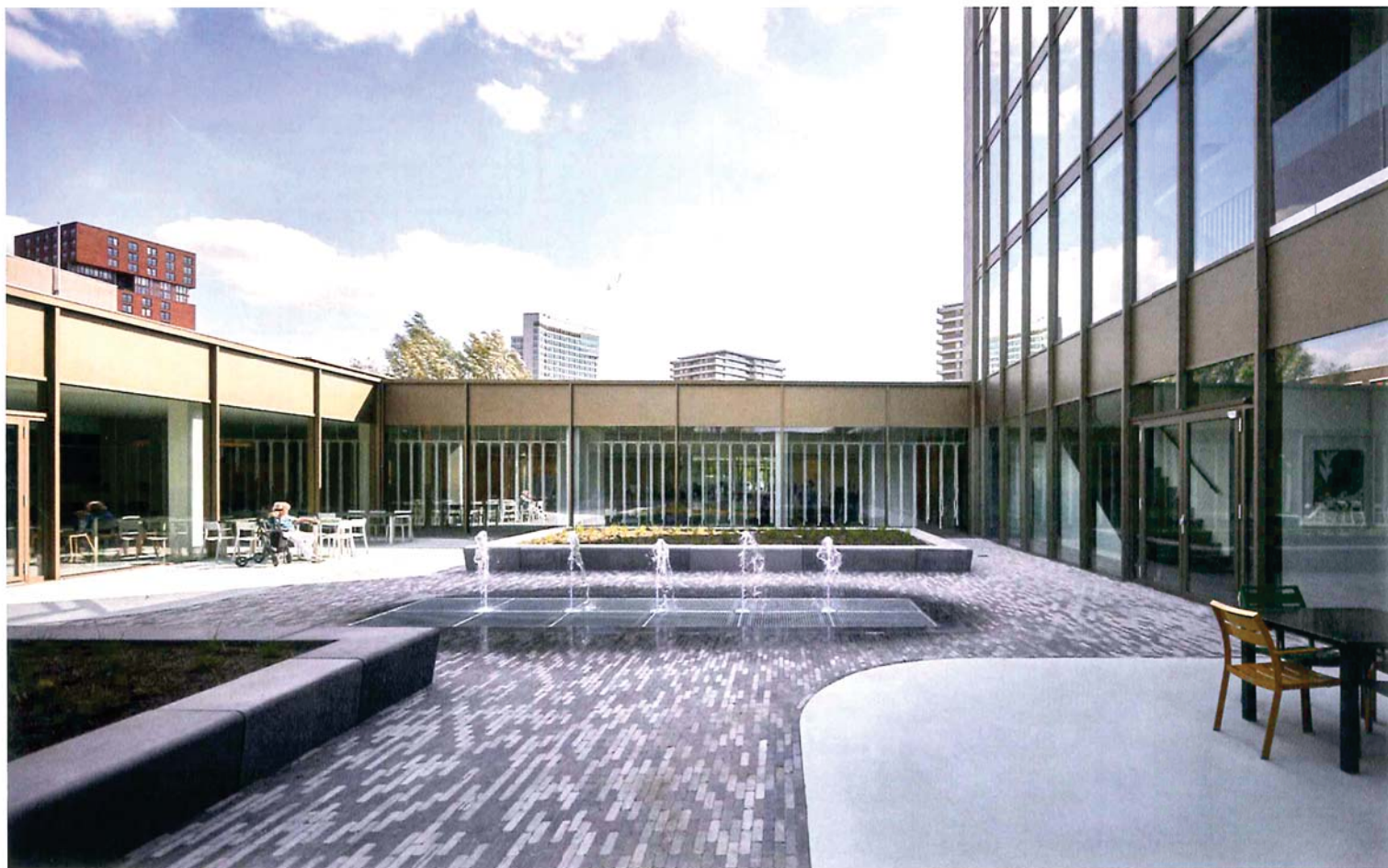
De binnenplaats neemt een belangrijke plaats in het ontwerp in; de gevel is bekleed met champagnekleurig aluminium
